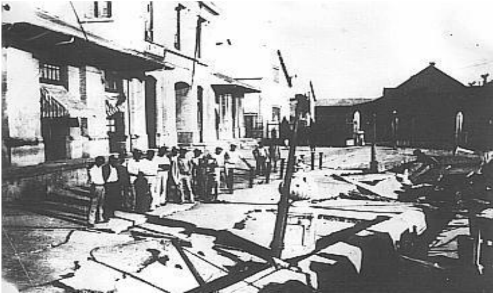
Figura 2: Foto. Licuefacción de los suelos en calle La Alameda, en Santiago de Cuba. Terremoto del 3 de febrero de 1932. Tomado de Chuy, 2002.
