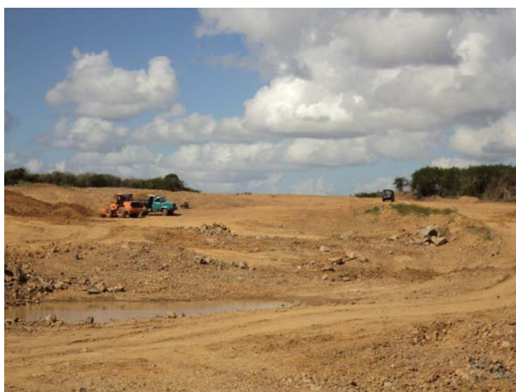
Foto No 4. Trabajos de desarrollo minero en el bloque 2Bb, destape.
