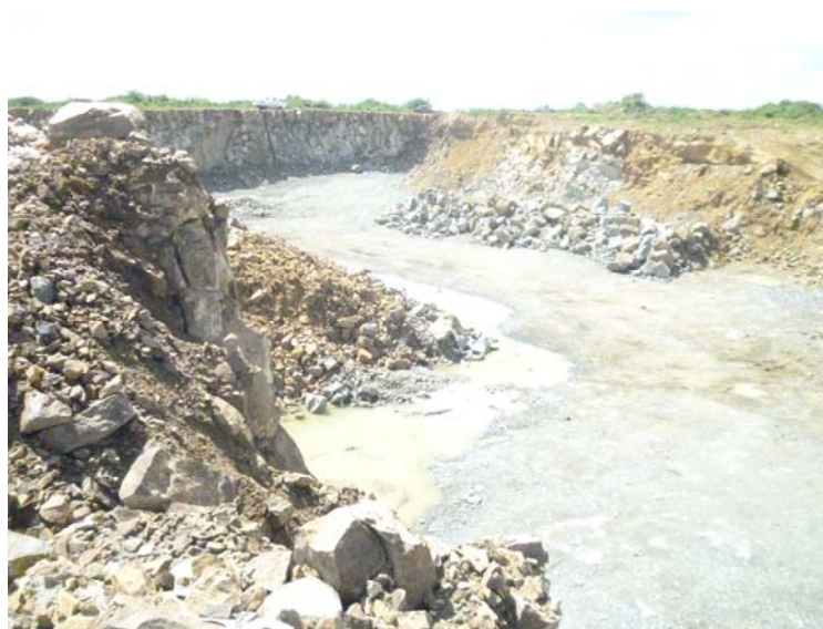
Foto No 5. Trabajos de preparación minera en el bloque 2Bb, nivel +46.0
