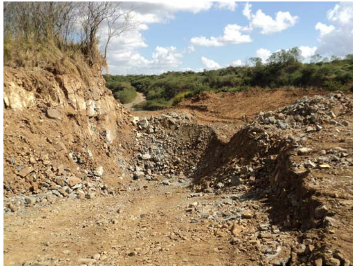
Foto No 3. Trabajos en la conformación de la trinchera.
