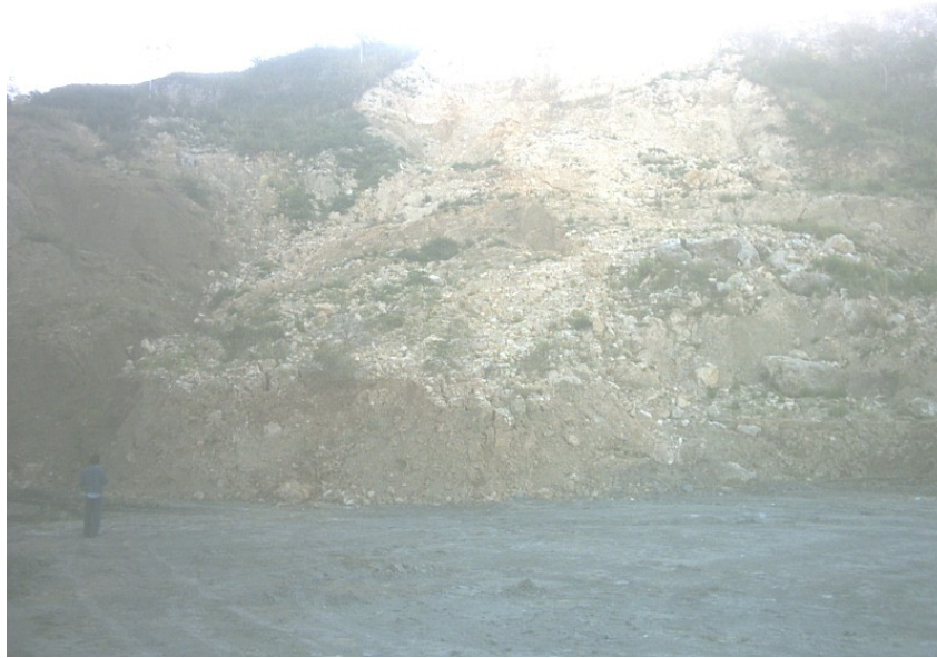
Foto 2.2.4 Deslizamiento traslacional en caliza margosa muy fracturada.
