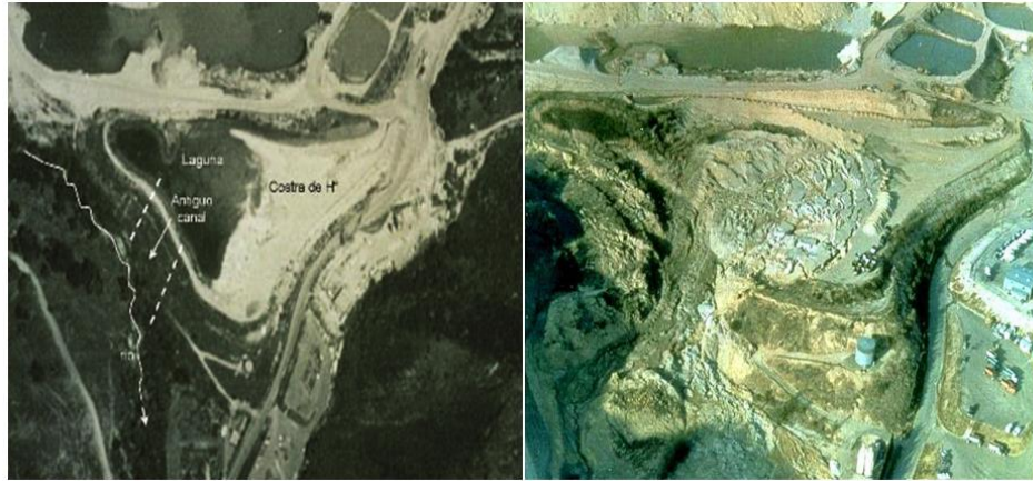
Foto 1 Vista aérea de la presa de Tapo Canyon previa a su rotura (izquierda) y rotura de la presa causada por el Terremoto de Northridge en 1994 (derecha) (Foto de Northridge Collection, Earthquake Engineering Research Center, University of California, Berkeley).
