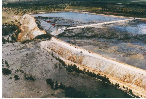
Foto 2 Rotura de la Presa de Aznalcollar, 1998. (Foto tomada de Oldecop. L.)
