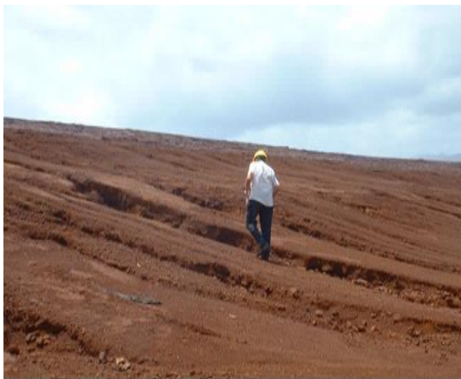
Foto 13 Erosión en surcos en el sector oeste de la presa de colas, Hernández, T. 2014
