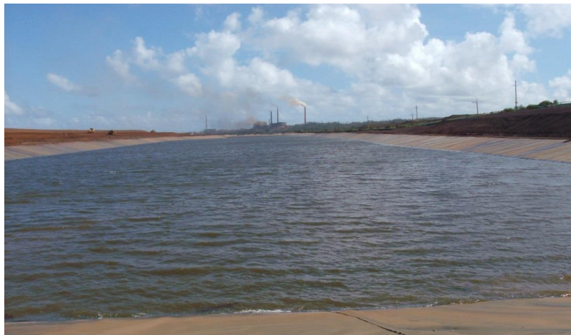
Foto 9 Estructura que almacena el agua de la presa de colas piscina sur
