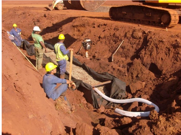
Foto 12 Construcción de un dren en la presa de colas de la ECPSA
