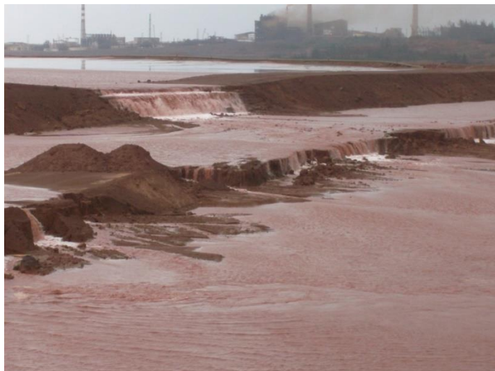
Foto 10 Fenómeno de sobrepaso por intensas lluvias en la presa de colas de la ECPSA.
