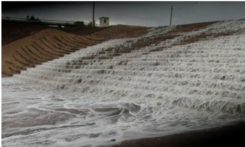
Foto 11 Aliviadero de emergencia de la presa de colas
