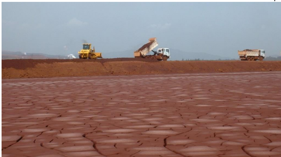
Foto 7 Proceso de construcción de la presa de colas de la ECPSA
