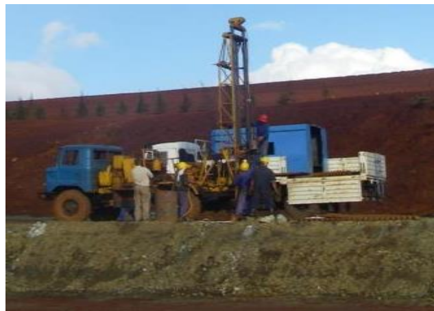
Foto 6 Perforaciones tipo SPT y CPT en la presa de colas
