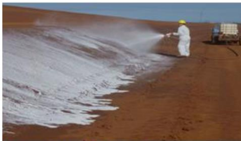
Foto 8 Sellaje al talud utilizando protección química, tomado de Hernández T. 2015
