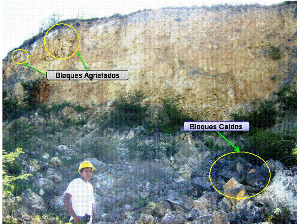
Figura 3.18 Imagen Talud de elevada altura y con mas de 80 grados de inclinación, parte suroeste del Yacimiento.
