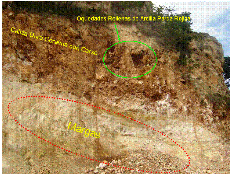
Figura 3.1 Caliza Dura con presencia de carso.
