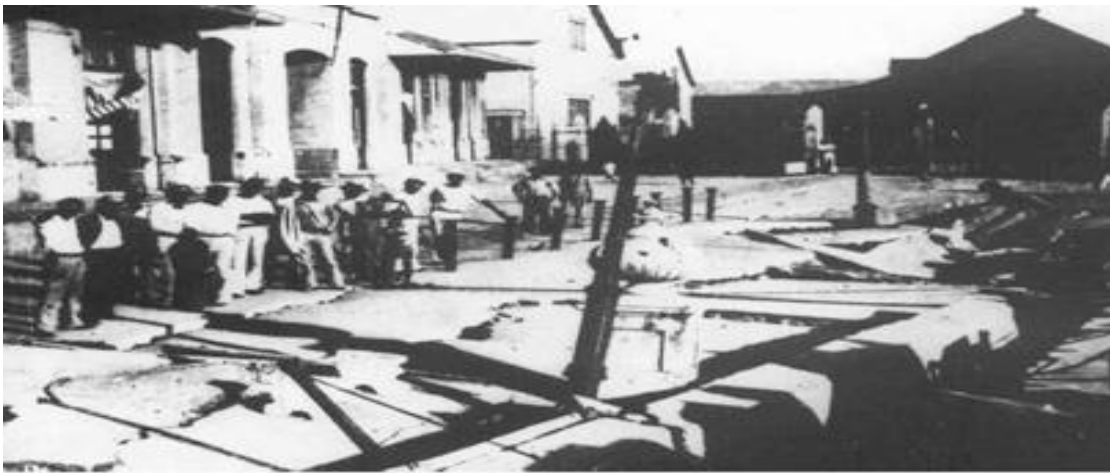
Figura 3: Foto. Licuefacción de los suelos en calle La Alameda, en Santiago de Cuba. Terremoto del 3 de Febrero de 1932. Tomado de Chuy, 1999.
