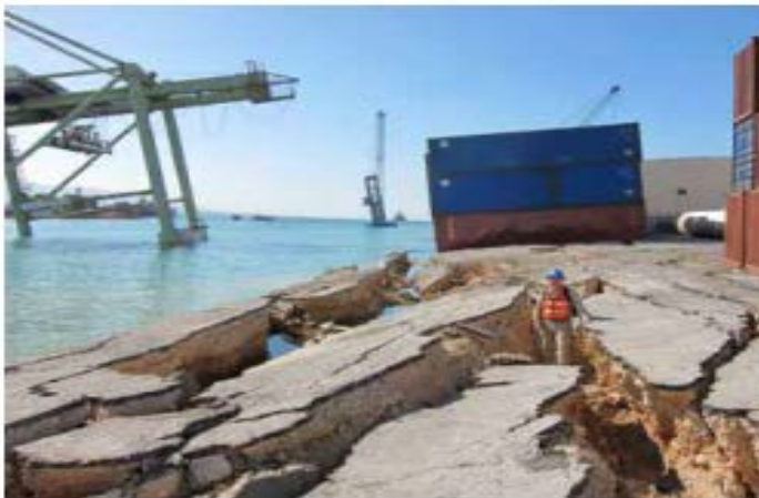
Figura 8: Foto que muestran en desplazamiento horizontal, en instalaciones portuarias en Puerto Príncipe, Haití.
