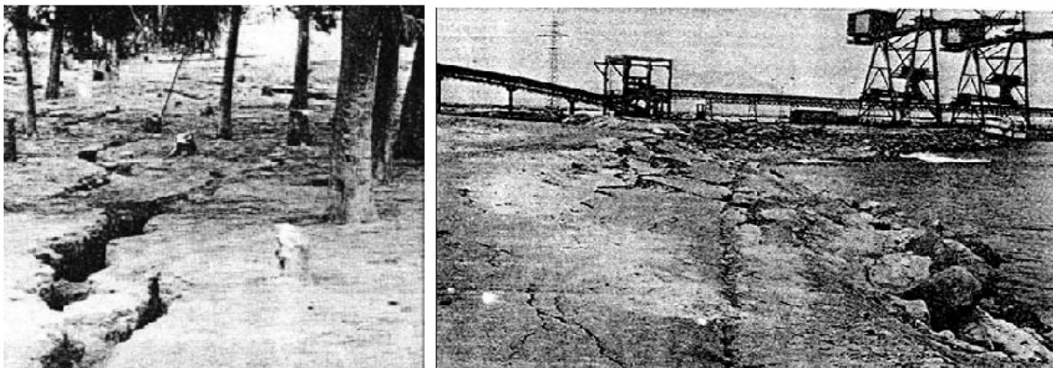
Figura 1: Izquierda: Agrietamiento del terreno en la llanura aluvial del Río Lacramarca. Derecha: Daño en el Puerto de Chimbote. Derrumbe del camino pavimentado. Una y otra imagen fue tomada luego del terremoto en Chimbote, Perú (1970).
