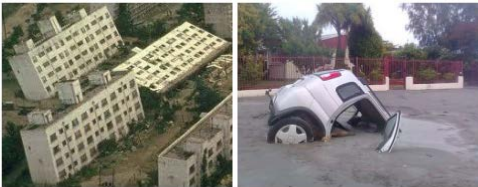
Figura 9: fotos que muestran la pérdida de la resistencia del suelo de soporte. A la derecha producto al terremoto de 1960 en Niigata, Japón y al izquierda al terremoto de 2011 en Chistchurch.
