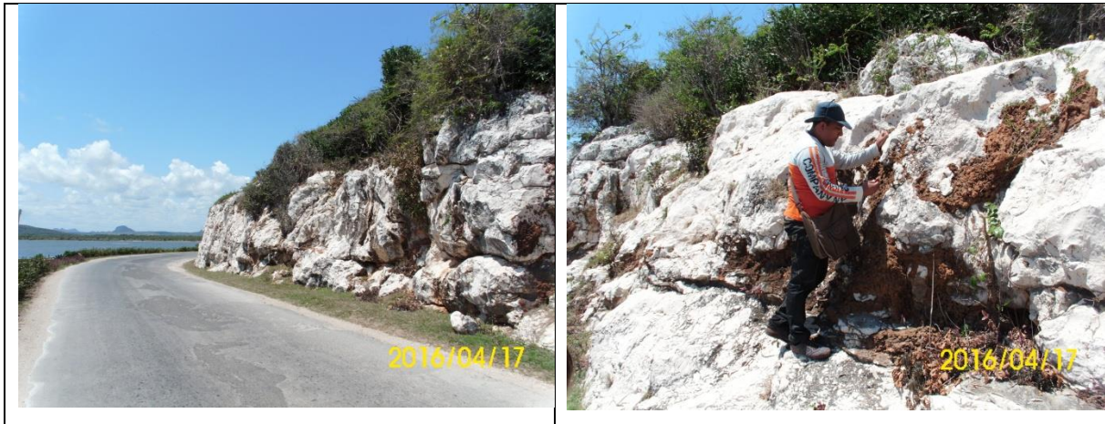
Figura 3.16 Fotografía del corte en el lado W de la carretera Holguín-Gibara
