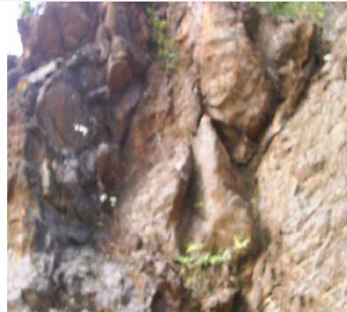
Deslizamiento en rocas
