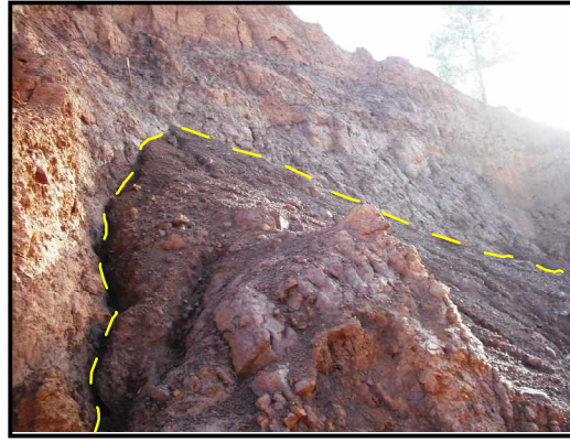
Foto 2. Deslizamiento en cortezas lateríticas.
