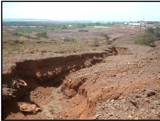
Foto 3. Erosión en cárcavas.
