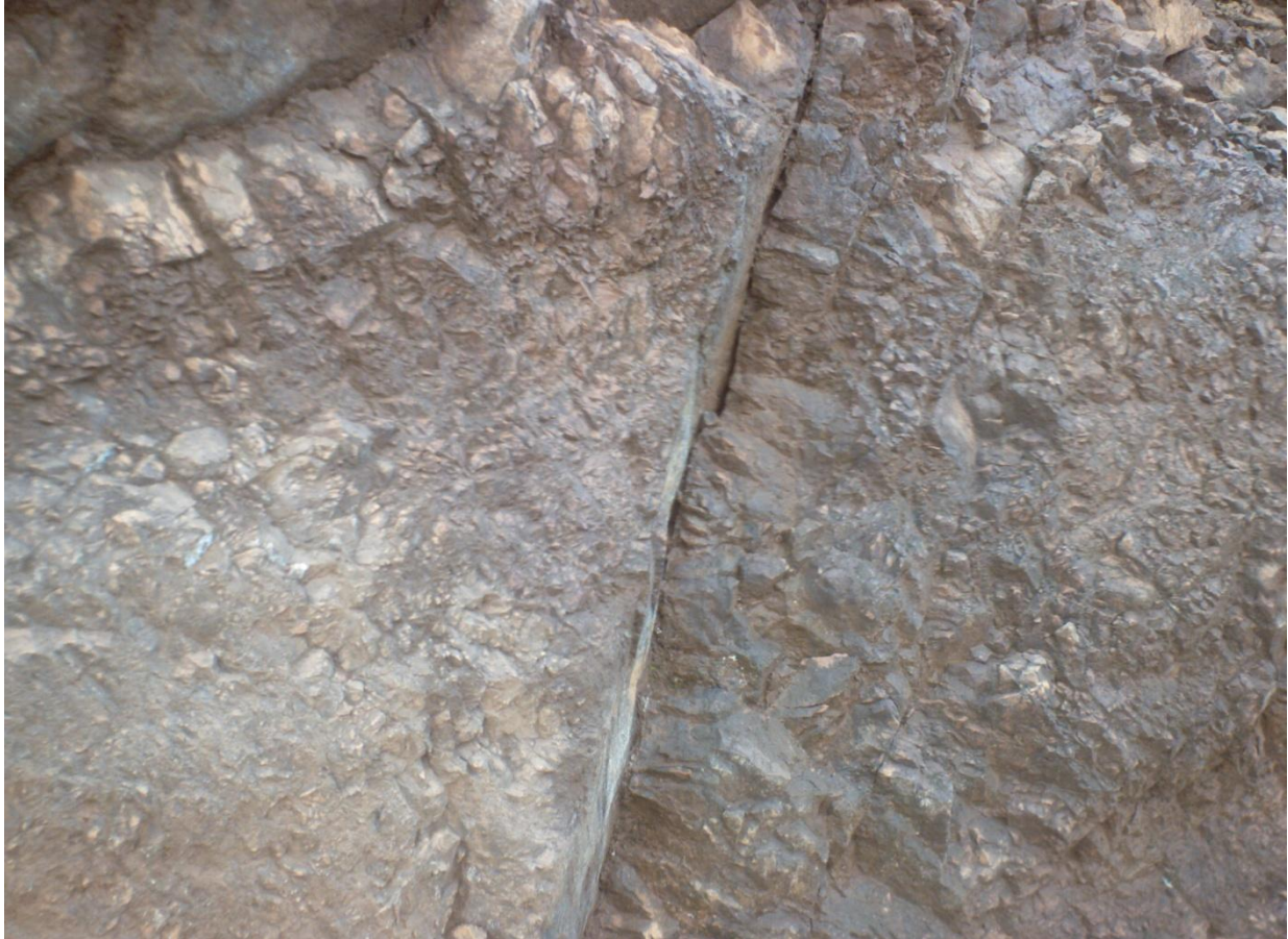
Foto 9. Zona de fracturación en las serpentinitas con desplazamiento NE.
