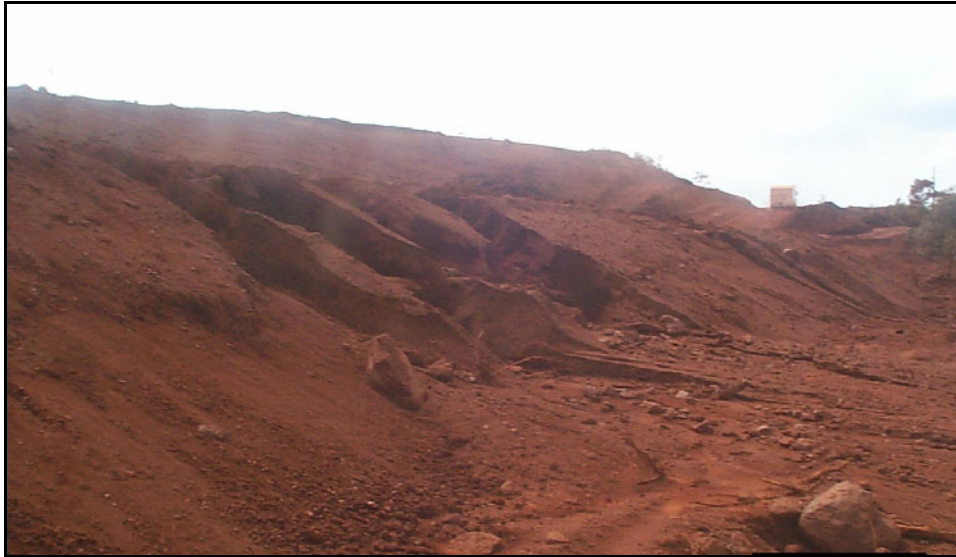
Foto 1.1. Procesos erosivos en taludes de cortezas lateríticas.
