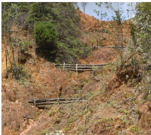
Foto 3.12 Sistema de estructuras transversales.
