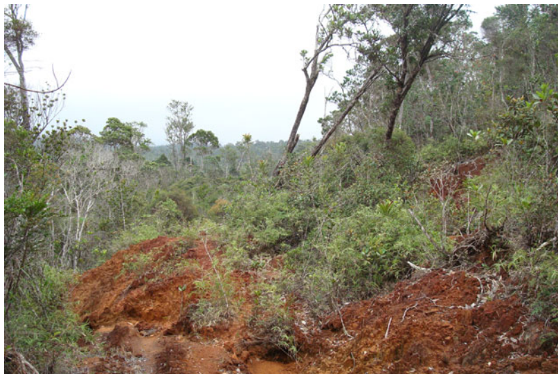
Foto 3.2. Deslizamiento rotacional en talud de camino principal cerca del cauce del río Piloto.
