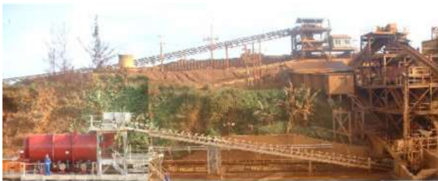
Foto 2. Vista de la planta de preparación de pulpa
