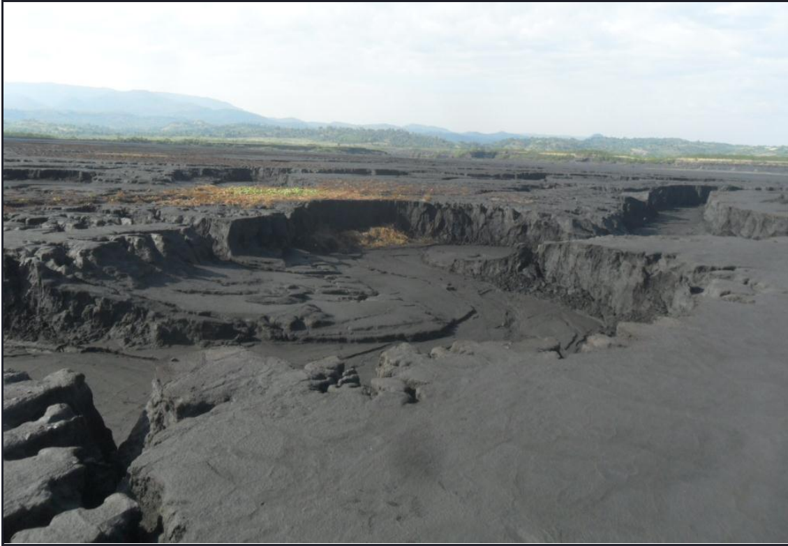
Foto # 4: Se observa el progreso en profundidad y ancho del sistema de cárcavas.
