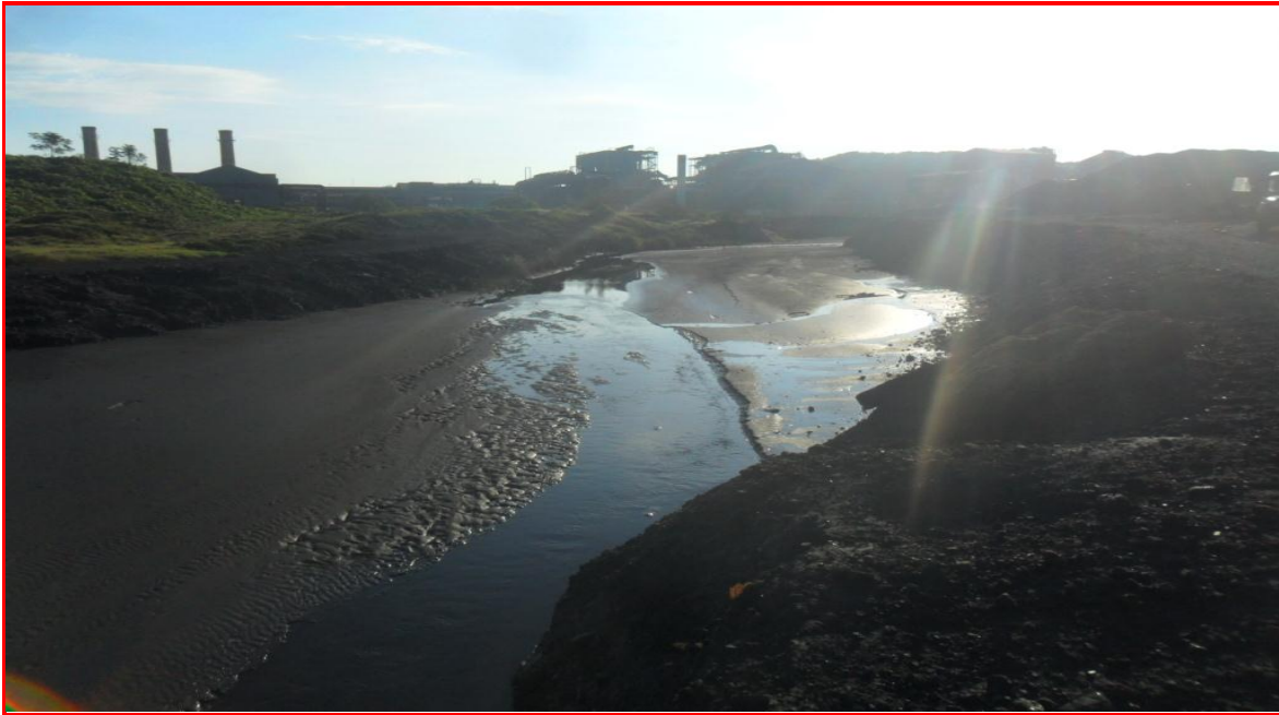
Foto # 13: Canal de desagüe de los desechos de las plantas procesadoras.
