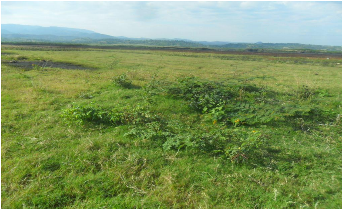
Foto # 18 Siembra para el cubrimiento del interior de la presa de colas.
