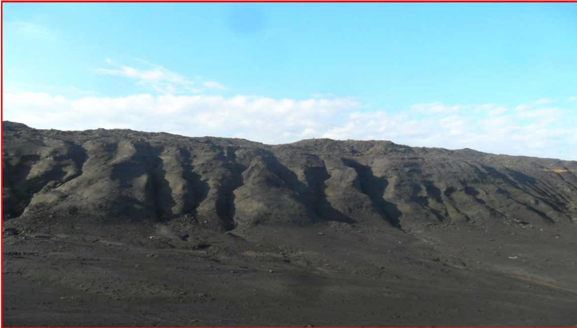
Foto # 12: Dique Norte: sistema de cárcavas que tributan al canal de desagüe de las plantas procesadoras.
